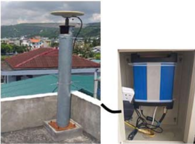
Hình 4. Hệ thống trạm CORS thiết lập tại thành phố Cẩm Phả, Quảng Ninh
